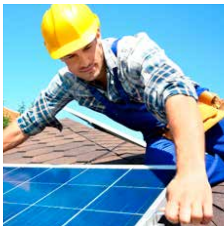
Ilyas 28 jaar // dakwerker “Met S2GO ga ik veilig het dak op”
